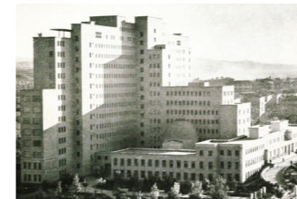
Residencia Sanitaria, Zaragoza
